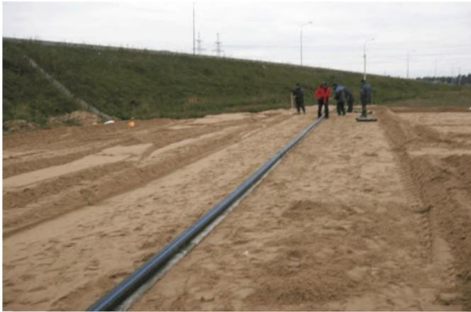
Рисунок 14 Устройство измерительного канала на КАД г. Санкт-Петербурга
